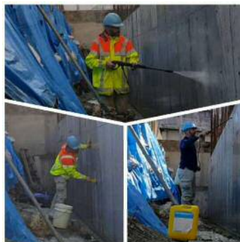
ベトロフレード施工方法
